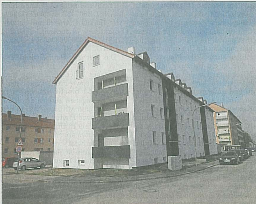
Die neu geschaffenen Wohnungen im Dachgeschoss.
